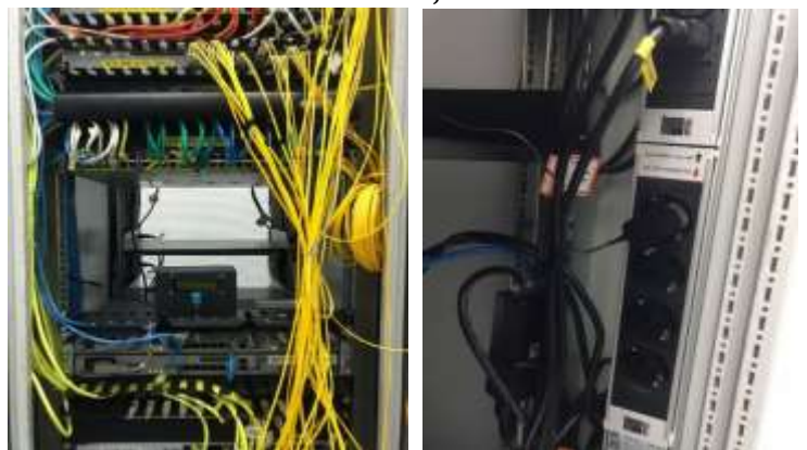
Gambar 3. 4 Lokasi Pemasangan Prototype
